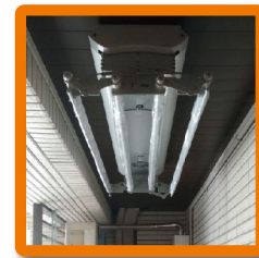
鋁天花板安裝
